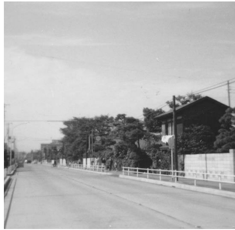
舗装工事終了 (S44年竣工頃)
